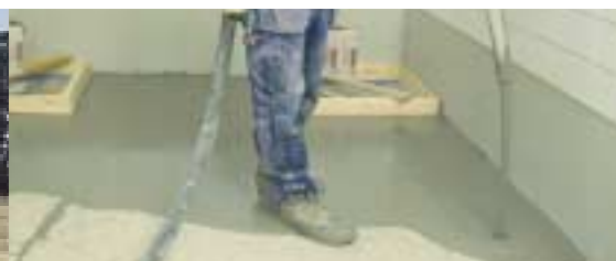
Peramin® tillsatsmedel har gjort det möjligt att utveckla en ny och mer effektiv golvutjämnningsteknik.
