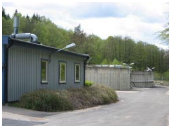
Avloppsreningsverket vid enheten i Perstorp.
