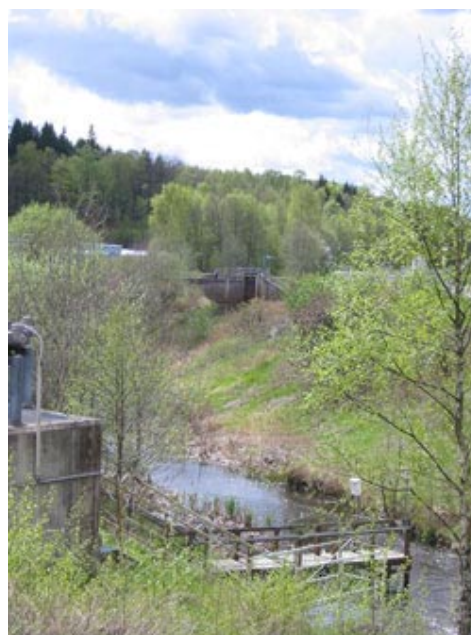
Säkerhetsdammen har en volym på 18 200 kubikmeter.
